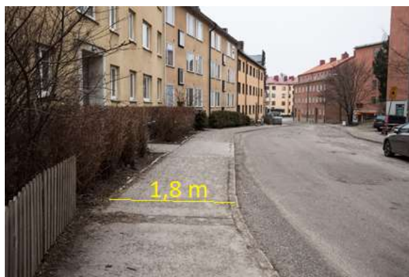
Figur 13: Tegelbruksvägen 4 – 14 där den totala bredden är 1,8 m. På motsatt sida av gatan varierar bredden mellan 1,2 och 2 meter.
