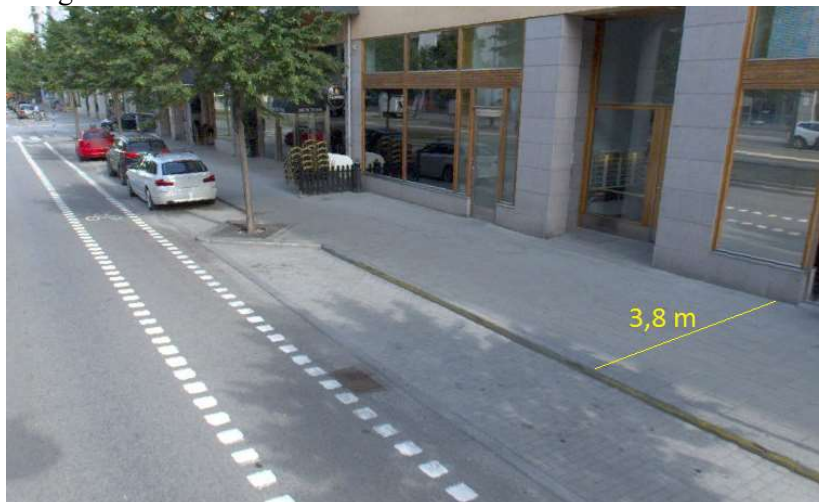
Figur 1: Hammarby Alle 127 där gångbanan är 3,8m bred. På motsatt sida av gatan är gångbanan 3 meter bred.
