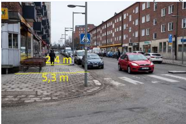
Figur 11: Störtloppsvägen 12 – 26 där den hinderfria bredden är 2,4 m och den totala bredden 5,3 m bredd. På motsatt sida av gatan varierar bredden mellan 3,5 och 4 meter.
