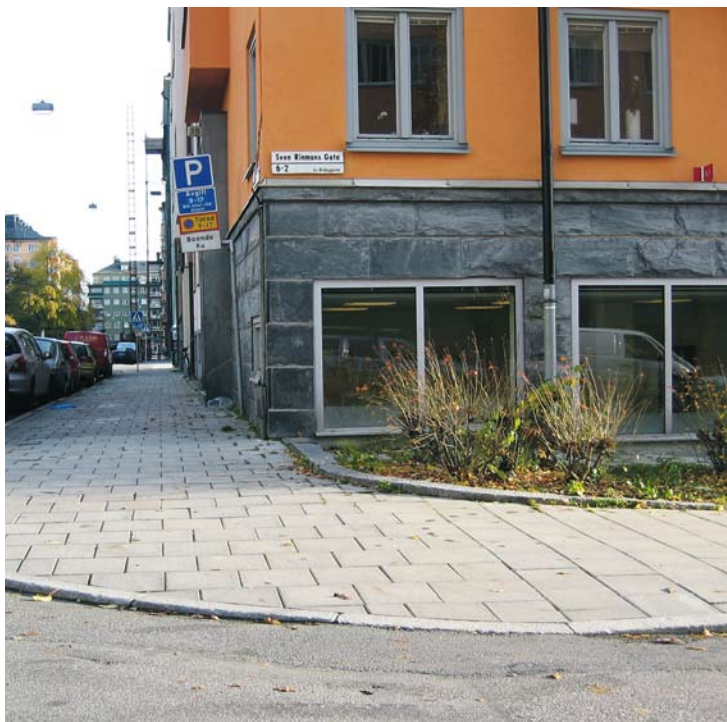
Kantstenssänkning innanför fasadliv. (Pontonjärgatan)
