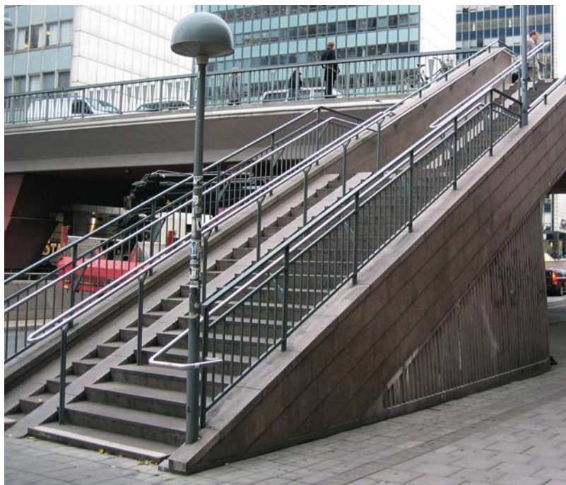
Fribärande trappor ska antingen byggas in eller märkas ut i markplanet. (Sveavägen)
