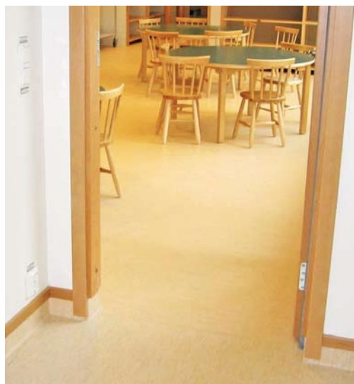
Tröskelfria passager underlättar för personer med rörelsesnedsättning. Kontraster runt dörrar och mellan vägg och golv underlättar för personer med synnedsättning. (Förskolelokal, Jämtlandsgatan)
