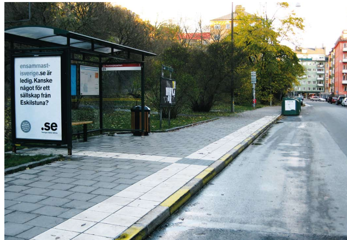
Busshållplats med vita och taktila plattor samt kantstenshöjd 16 centimeter. (Pontonjägatan)
