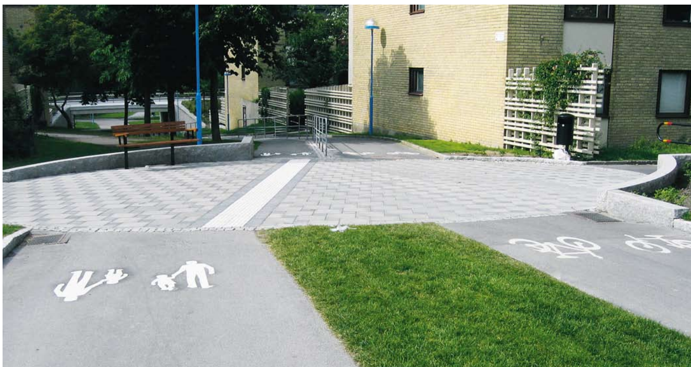
Exempel på utformning av taktilt och visuellt ledstråk. (Södra stadsparken i Rinkeby)
