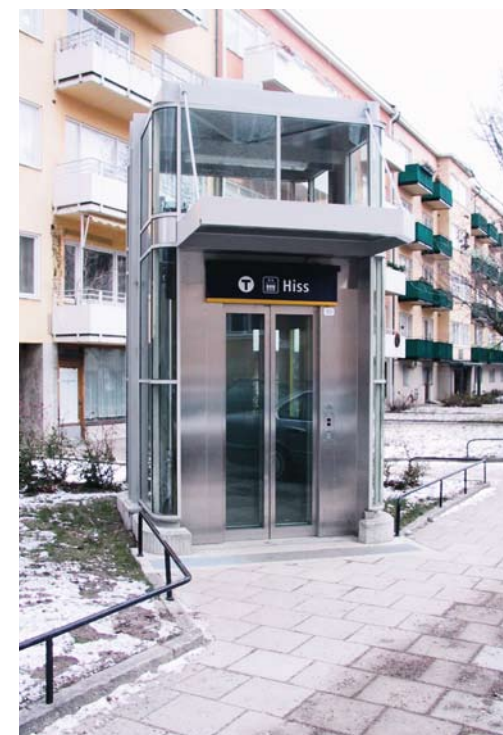
Hissar ska vara tydligt skyltade och ha automatiska skjutdörrar. (Brantingsgatan)
