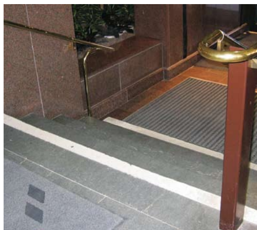
Trappan är kontrastmarkerad på första och sista steget. (Tekniska nämndhuset, Fleminggatan)
