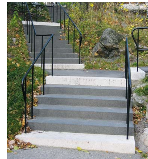
Trappor med hela steg i kontrasterande färg och ledstänger som fortsätter förbi vilplanen. (Sulitelmavägen)
