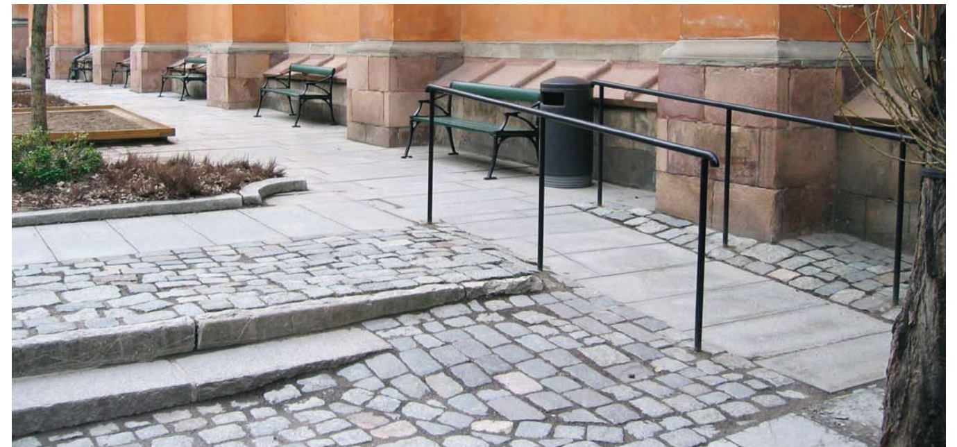
Trappstegen har kompletterats med ramp. (Storkyrkan)
