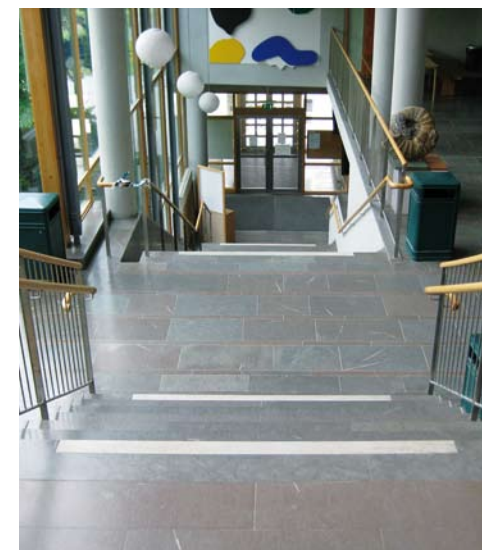
Kontrastmarkering i trappa. (Geovetenskap, Stockholms universitet)
