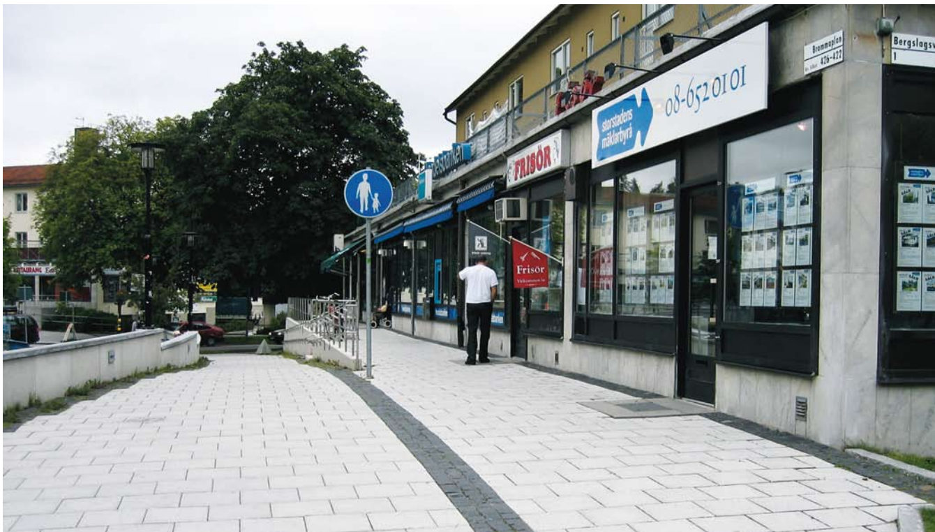
Entréer som är tillgängliga för alla. (Brommaplan efter ombyggnad)
