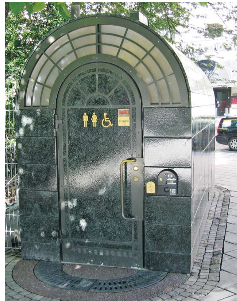
Bilden visar Stadstolettens utvändiga utseende. Myntinkastet är möjligt att nå från rullstol och det finns ingen nivåskillnad vid entrén. (Berzelii park)
