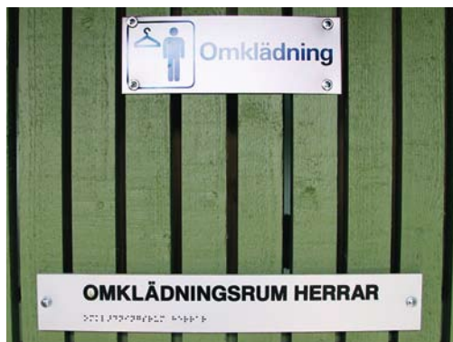
Skyltning med tydlig symbol och text samt taktil text. (Smedsuddsbadet)
