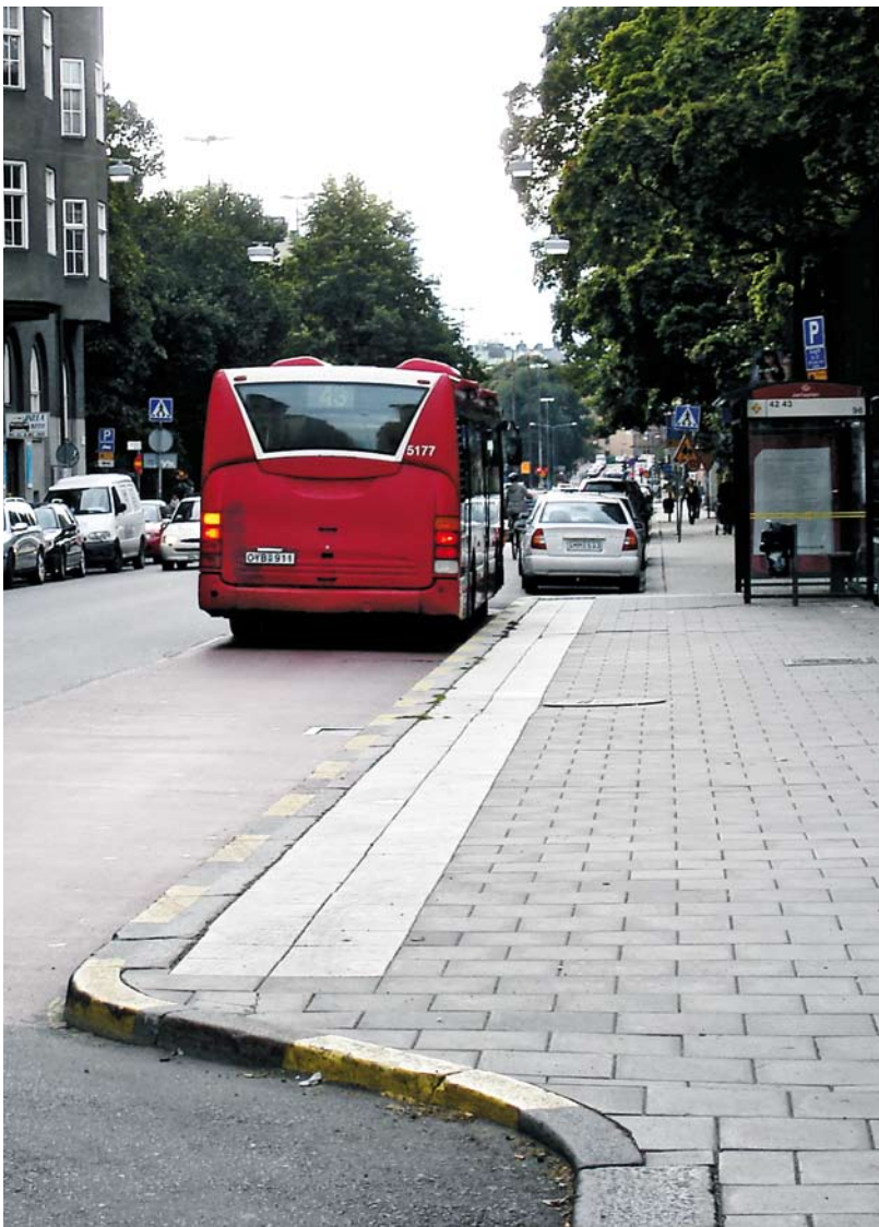
Utformning av utbyggd busshållplats. (Jarlaplan)
