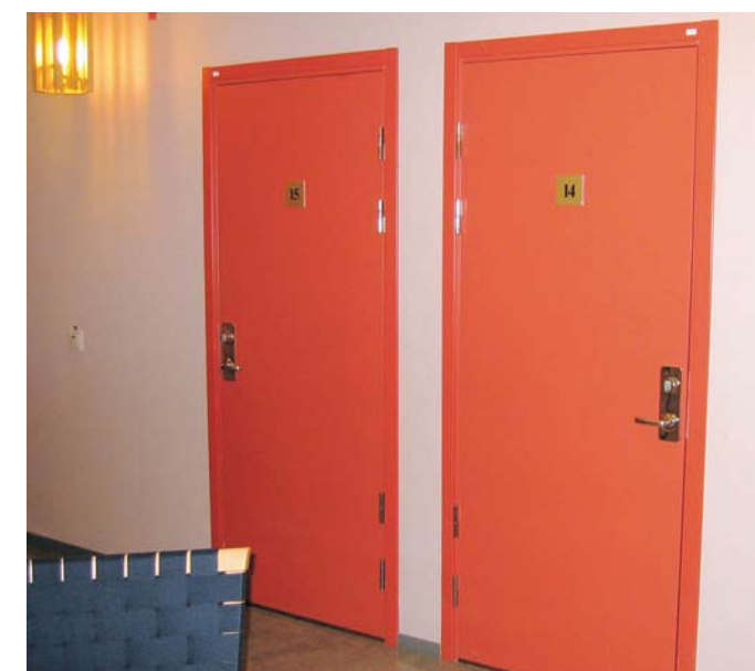
Dörrar i en färg som kontrasterar mot väggen. (Ersta sjukhus)
