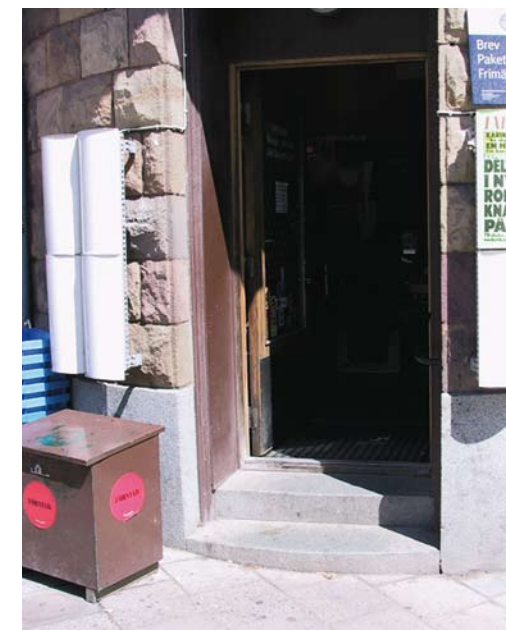
Entré före ombyggnad. (Hantverkargatan)
