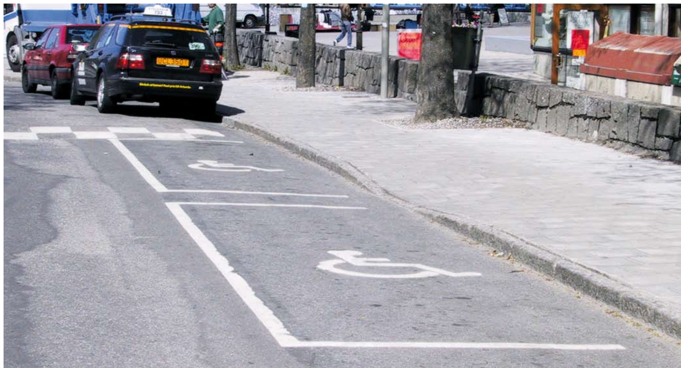
Kantstenssänkning vid handikapparkeringsplats. (Hökarängens centrum)
