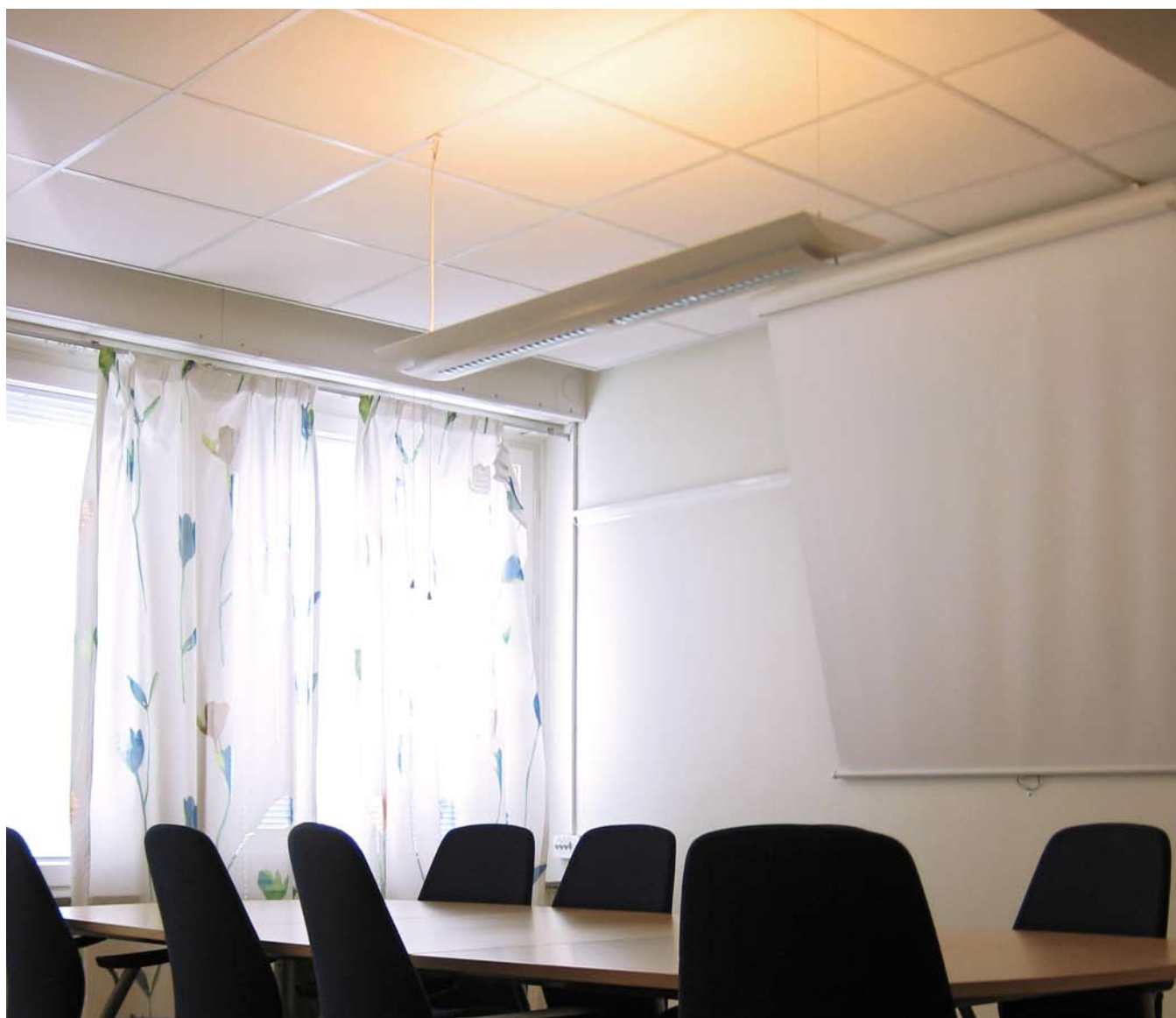
Sammanträdesrum med akustikplattor i taket. (Tekniska nämndhuset, Fleminggatan)
