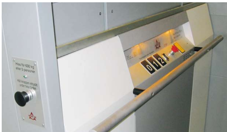
Manöverpanel med tydliga kontraster samt god belysning. (Åkeshovs sim- och idrottshall)
