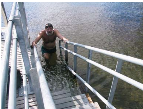
Badtrappan har greppvänliga ledstänger på två olika höjder. (Smedsuddsbadet)
