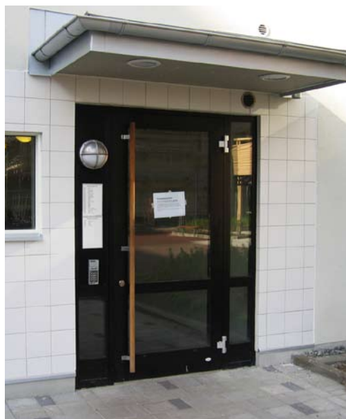
Exempel på dörrhandtag som är utformat så att det kan öppnas även av personer med lättare rörelsenedsättning. (Solberga gård, Älvsjö)
