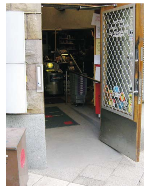
Entré efter ombyggnad. (Hantverkargatan)
