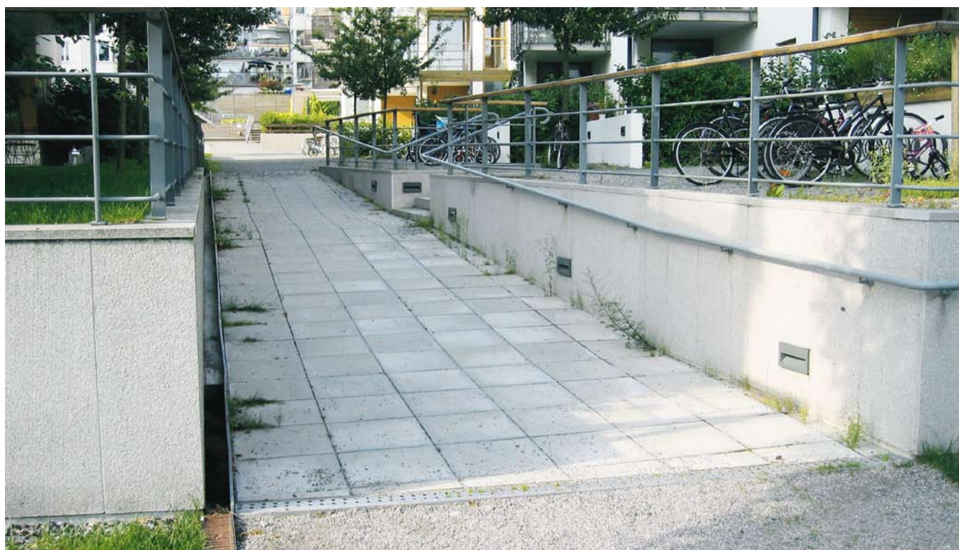
Ramp på kvartersmark. (Hammarby Sjöstad)
