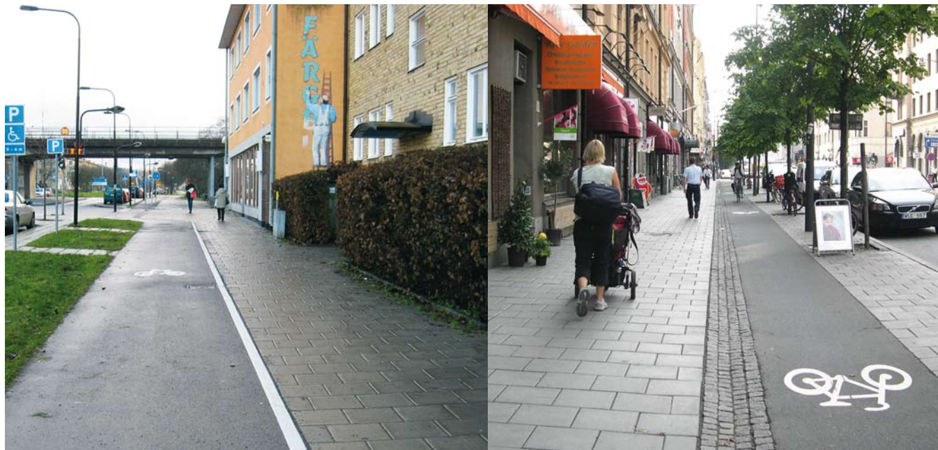
Betongplattor på gångbanan och asfalterad cykelbana samt separering mellan ytorna i form av en vit linje respektive smågatsten utgör en tydlig separering. Cykelsymbolerna förtydligare ytterligare. (Sockenvägen, vänstra bilden, samt Vasagatan, högra bilden)
