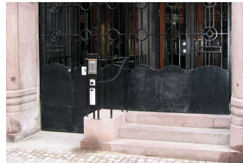
Befintlig entré som efter ombyggnad blivit tillgänglig för personer med rörelsenedsättning. (Stora Nygatan)
