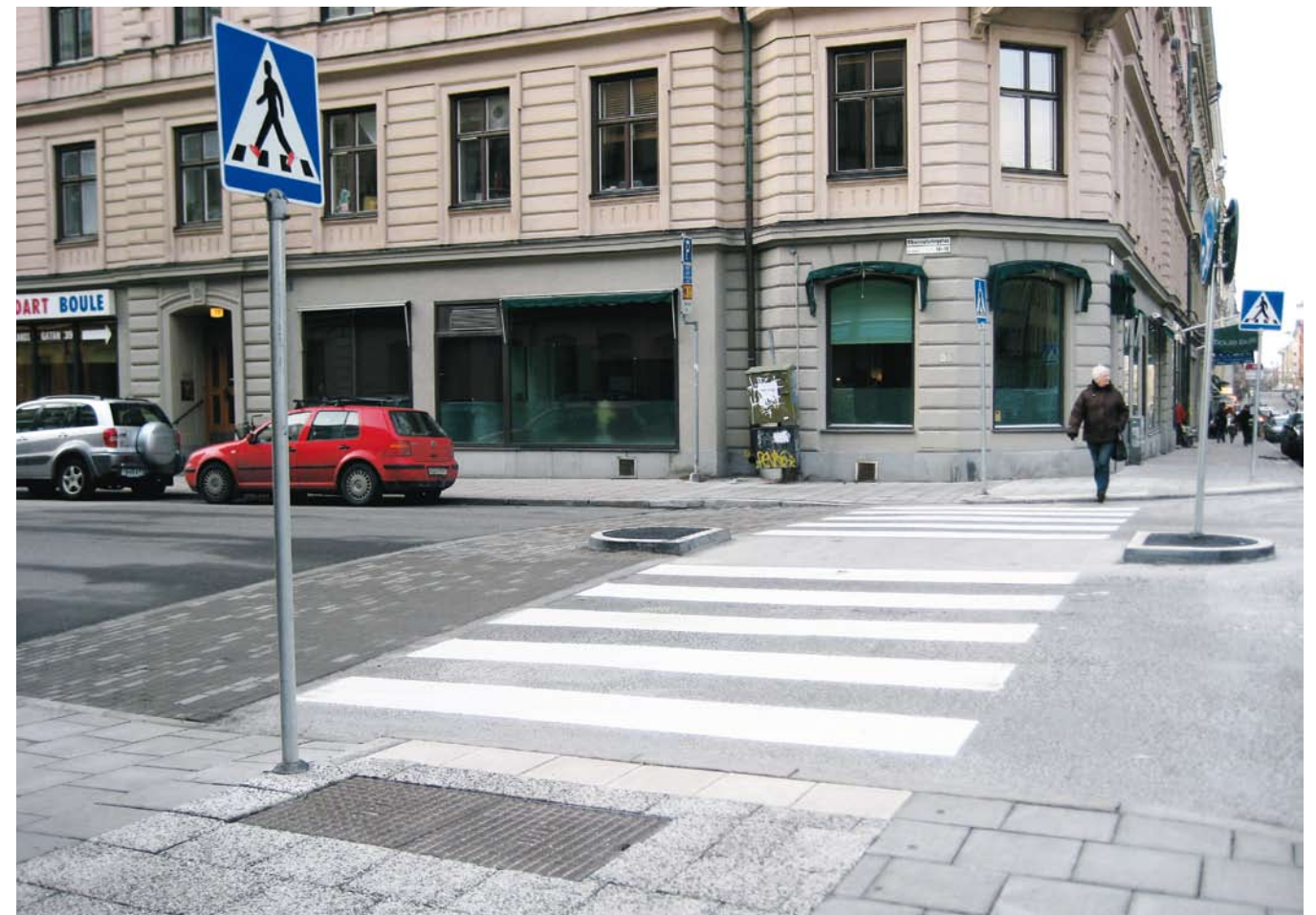
Trafiksäkerhetshöjande åtgärd i form av upphöjt övergångsställe. (Observatoriegatan–Upplandsgatan)
