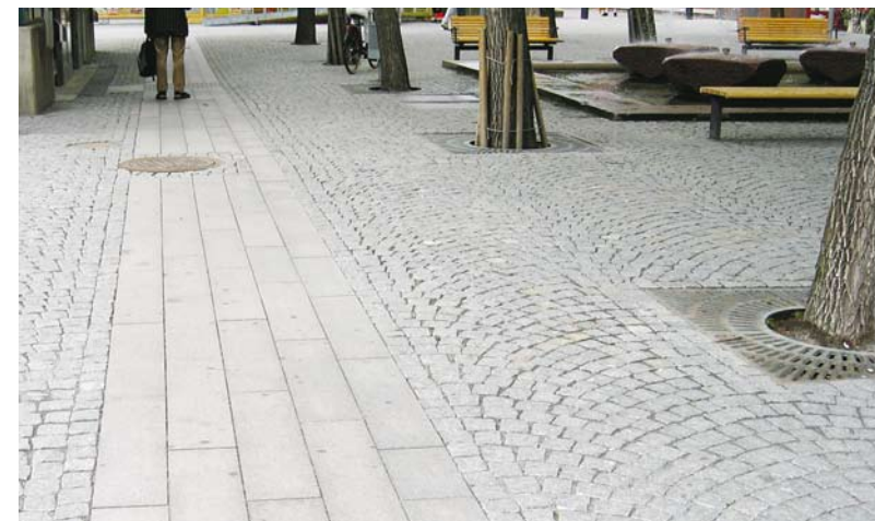
Ojämn markbeläggning har kompletterats med jämn markbeläggning. (Akalla centrum)
