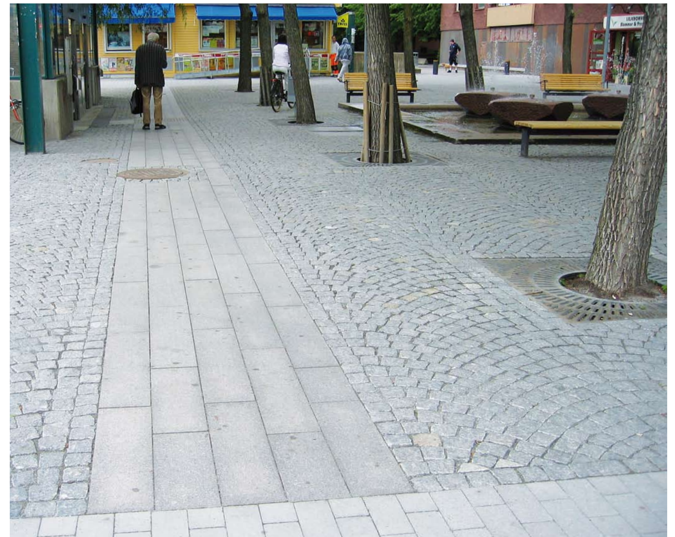
Smågatstensyta där slät gångyta av hällar fällts in. (Akalla)
