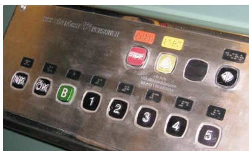
Lämplig utformning av manöverpanel i hiss. (NHR, S:t Eriksgatan)
