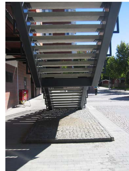
Fribärande trappa som är markerad i markplanet. (Sibeliushöjden, Akalla)
