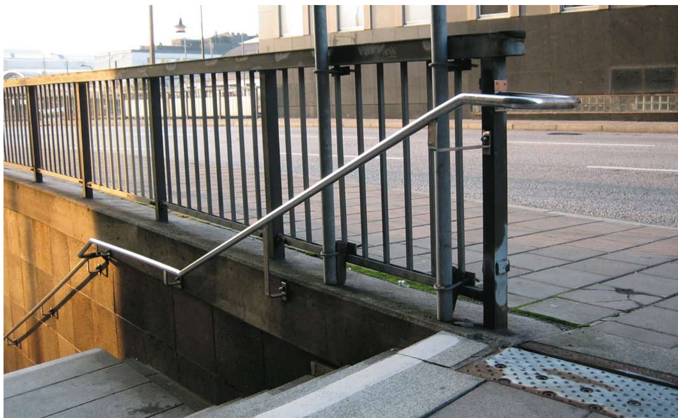
Exempel på utformning av ledstång. (Herkulesgatan)
