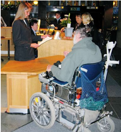
Reception med lämplig höjd för personer som använder rullstol. (Tekniska nämndhuset, Fleminggatan)
