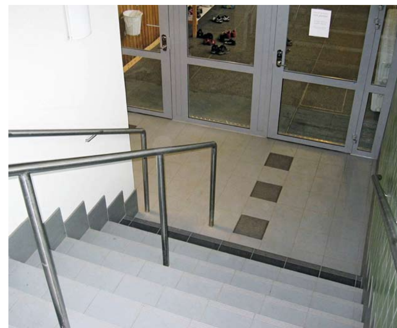
Ledstänger i trappa. (Åkeshovs sim- och idrottshall)
