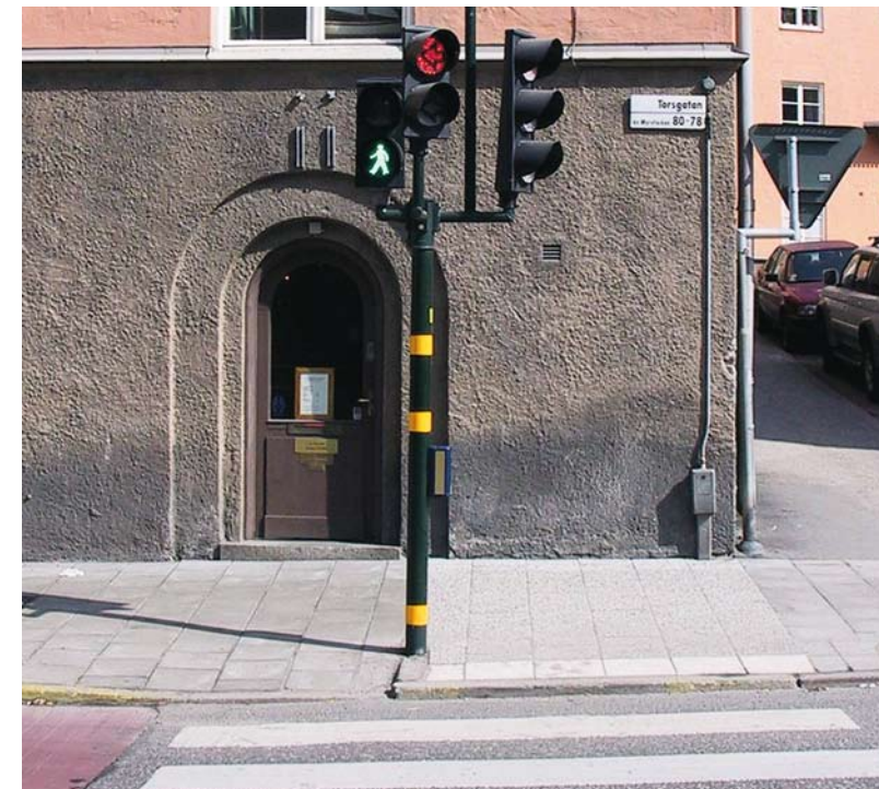
Trafiksignal med kontrastmarkering. (Torsgatan)
