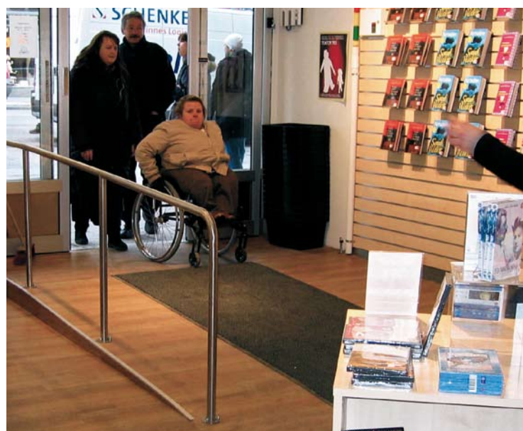
Nivåskillnaden vid entrén har byggts bort med invändig ramp. (Akademibokhandeln, S:t Eriksgatan)
