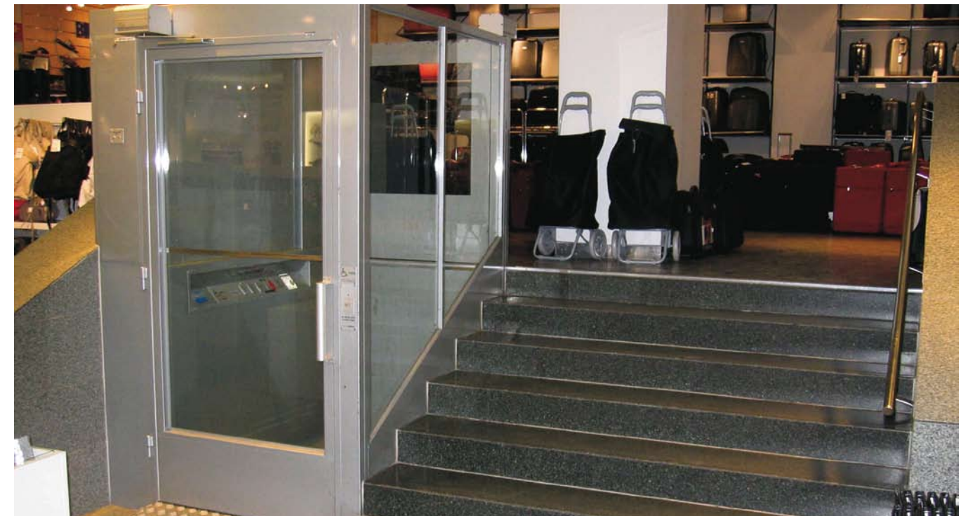
Trappa har kompletterats med hiss. (Åhléns City)
