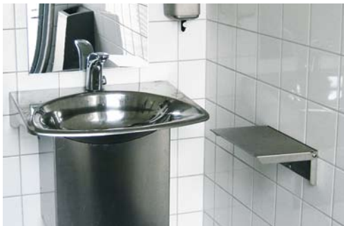
En hylla vid handfatet är viktigt för personer som är stomiopererade. Hyllan är upp- och nedfällbar. (Strandvägskajens café)
