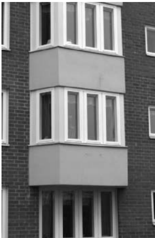
Figur 2. Stort burspråk som kan användas vid bullerinfall längs fasaden för att begränsa ljudnivån inomhus med vädringsöppet fönster.
