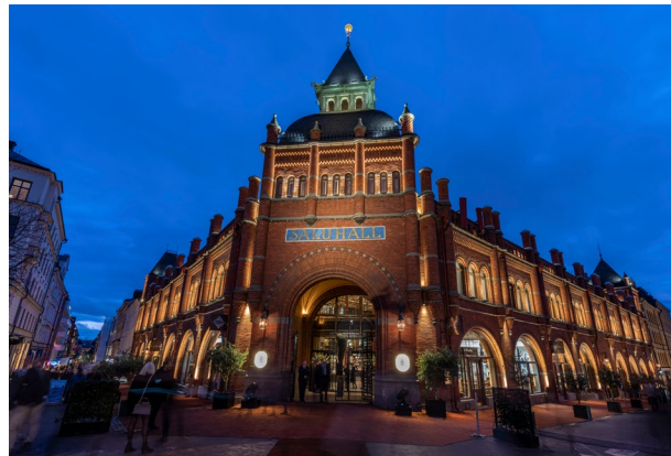
2. Fasadbelysningen på Östermalmshallen ger torget atmosfär.
