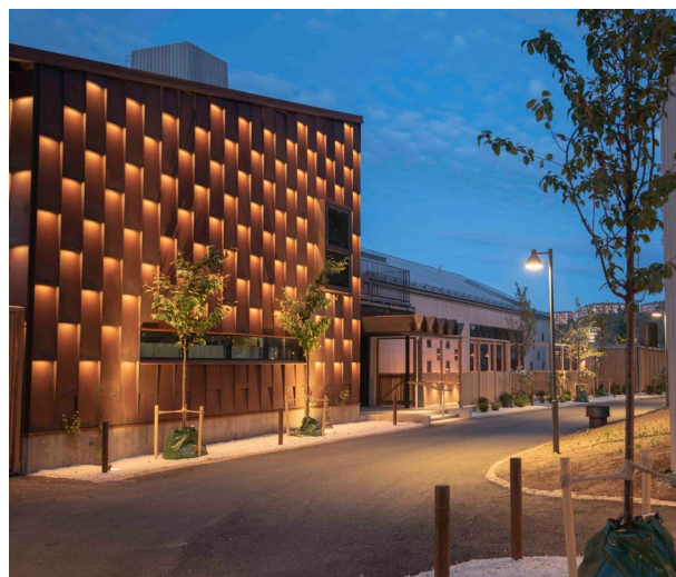
2. Fasadbelysning på restaurang Aira, Djurgården.
