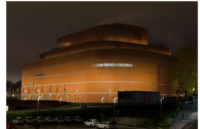
3. Fasadbelysning som samverkar med storskalig arkitektur på kraftvärmeverket i Hjorthagen.
