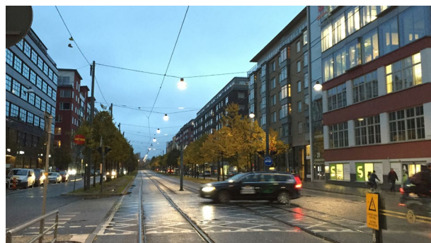
1. Spårgata med linspända armaturer från kontaktledningsstolpar och fasad.
